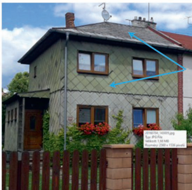
Foto č. 1 - Eternitové šablony použité jako střešní krytina i jako obklad fasády.
