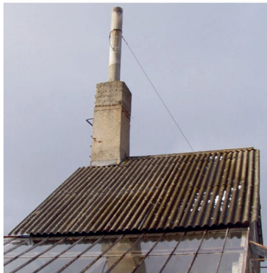
Foto č. 2 - Eternitové vlnité desky jako střešní krytina a azbestocementová roura jako komínový nástavec.
