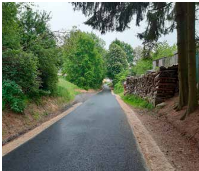
Oprava místní komunikace na p.č. 4749/1, Kunžak
